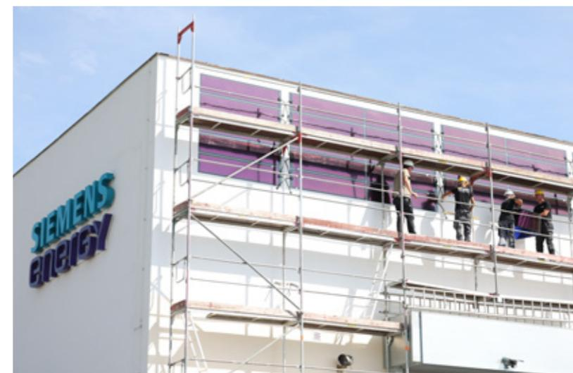
Installation von flexiblen PV-Folienmodulen auf dem Transformatorenwerk Nürnberg.
