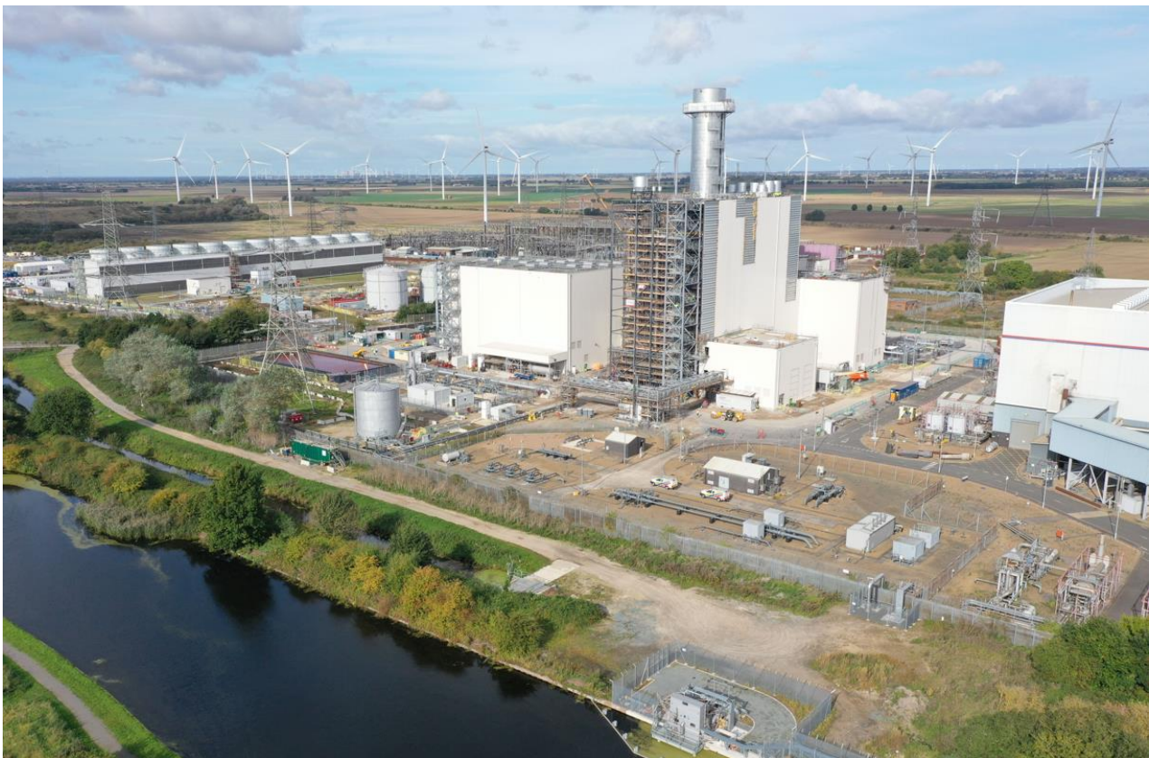
Keadby 2 là một nhà máy điện chạy bằng khí đốt với tuabin HL với công suất 840MW mới ở North Lincolnshire, UK
